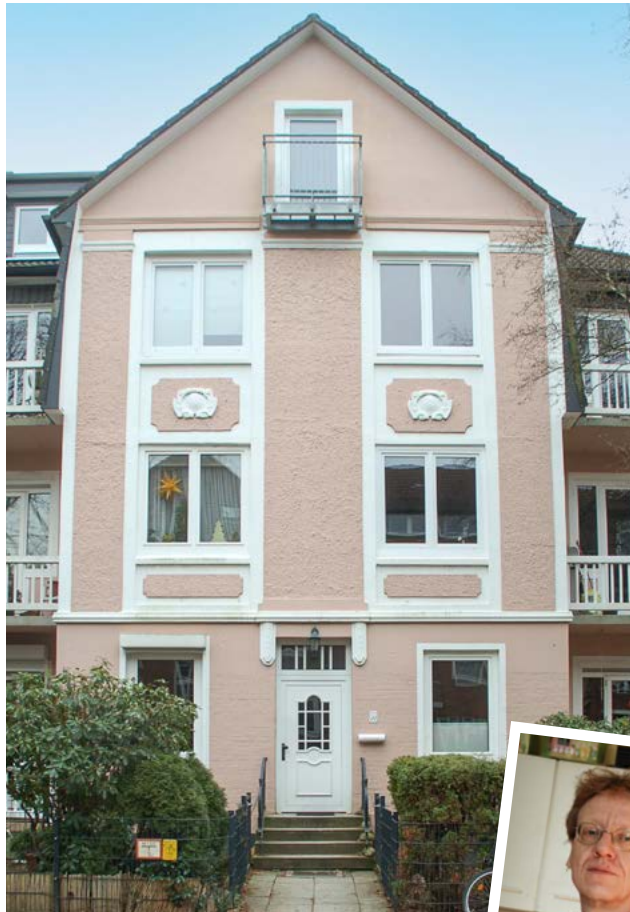
1912 gebaut: das Haus in der Rübenhofstraße in Fuhlsbüttel. Rechts: Kämpft um seine Wohnung, in der er seit mehr als 50 Jahren lebt: Mieter Thomas Lücking.
